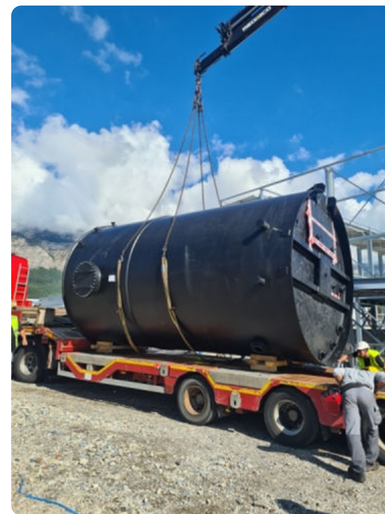
Ici déchargement et pose d'une cuve de traitement des boues biologique sur STEP d'industrie de micro électronique dans l'Isère (38)
