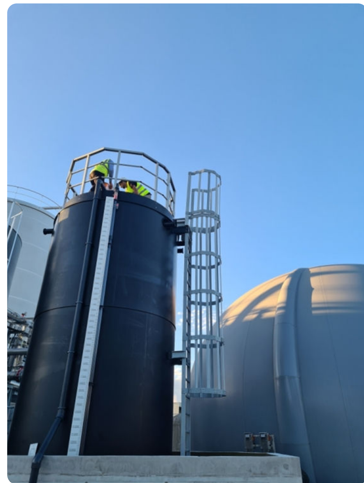
Installation d'une cuve de Chlorure ferrique dans une papeterie de la Drôme (26)
