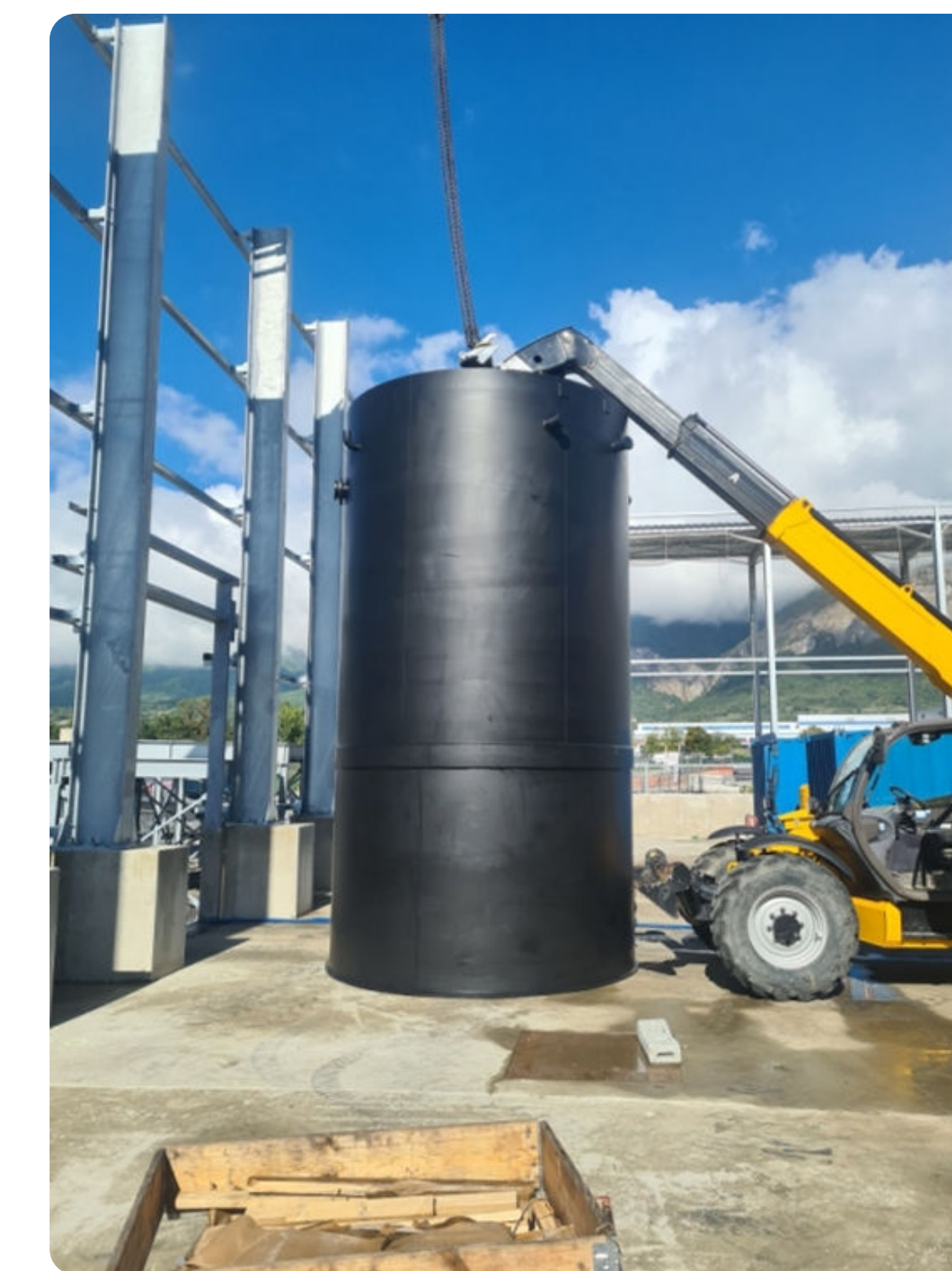
Ici déchargement et pose d'une cuve de traitement des boues biologique sur STEP d'industrie de micro électronique dans l'Isère (38)
